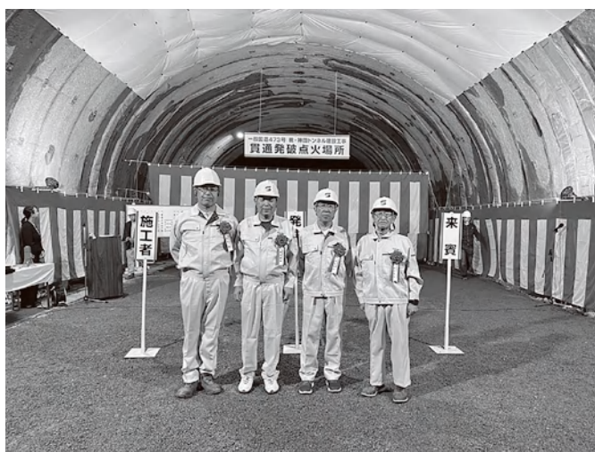
槻・神田トンネル貫通式 ▲▶
