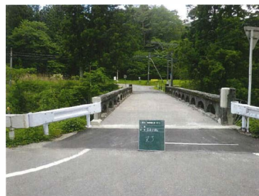
118 名倉大橋 修繕工事
