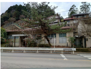
解体予定：段嶺窓口センター外観
