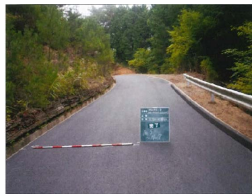
103 林道三橋線 舗装工事 完了
