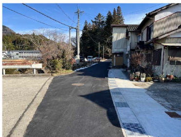
町道向木屋白山線 側溝布設工事
