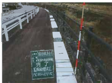
側溝蓋の取替（津具小学校区）
