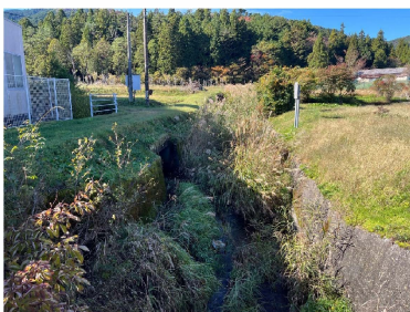
普通河川船石沢 河川浚渫前
