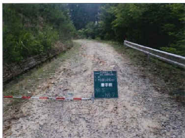
林道三橋線 舗装工事 着手前
