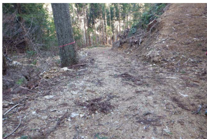
開設作業道 (神田地内)
