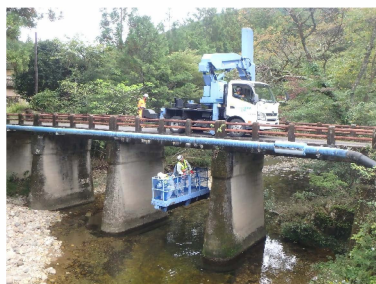
橋梁点検の状況（点検車）
