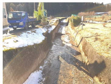
120 普通河川船石沢 河川浚渫後
