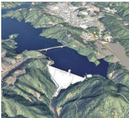
設楽ダムは、愛知県北設楽郡設楽町の豊川に建設中の重力式コンクリートダムである。堤高129m、堤頂長360m、総貯水容量は約9,800万m<sup>3</sup>。洪水調節、流水の正常な機能維持、水道・農業用水の供給を目的としている。流域の治水・利水に貢献するほか、水源地域対策特措法に基づき地域振興も併せて進められている。完成は2034年度予定。
