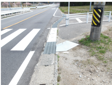
横断歩道設置によるガードパイプの設置（名倉小学校区）
