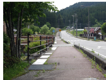
側溝蓋の取替（津具小学校区）
