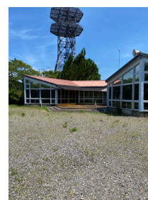
解体予定：田口児童館外観
