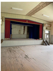
解体予定：旧清嶺中学校講堂内
