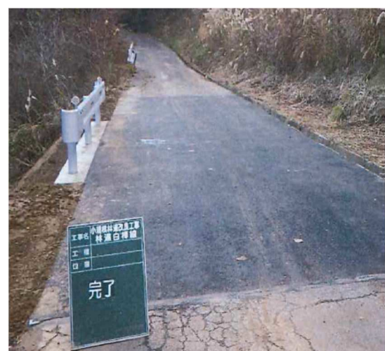
林道白樺線 ブロック積工
