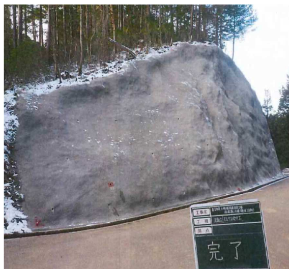
林道鹿ノ子線 モルタル吹付工
