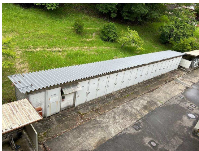
谷下団地倉庫屋根塗装修繕
