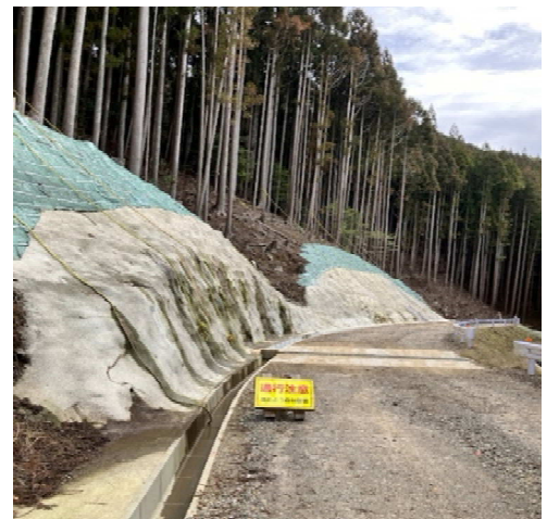
林道中口尤線開設状況
