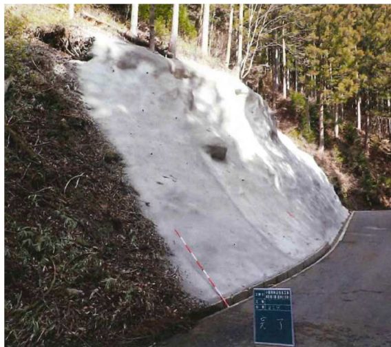
林道境川線 モルタル吹付工
