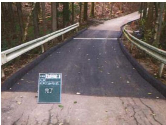
林道小槓立線 舗装・排水修繕
