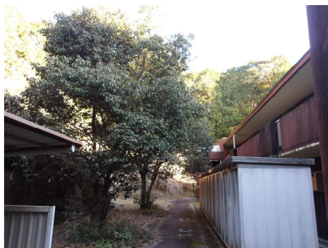
町営折地団地支障木伐採
