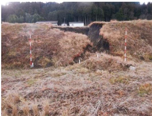
農地災害復旧工事 （西納庫） （着手前）
