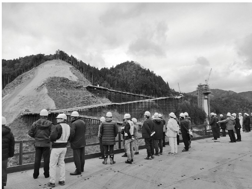
◀ ダム本体工事掘削現場
