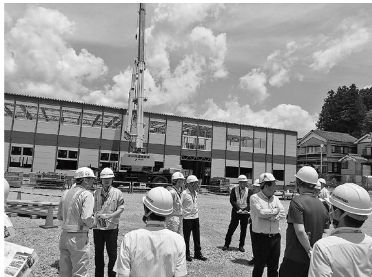
▲ 設楽ダム本体工事宿舎等建築現場
