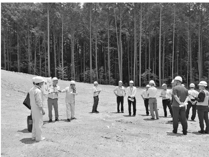
◀ 国道257号清崎安沢地内ミニバイパス工事現場
