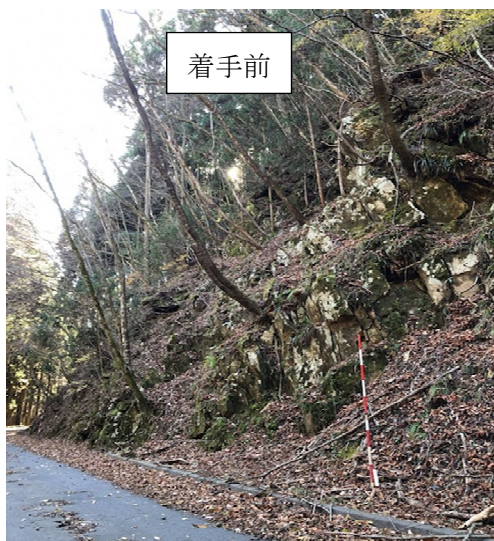
林道境川線（東納庫地内）法面吹付
