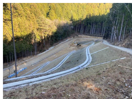
笹平奴田小松線（状況）
