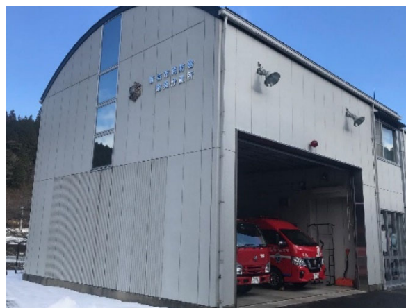
新城市消防署津具分遣所
