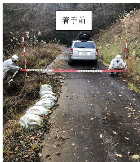
林道白樺線（津具地内）路側ブロック
