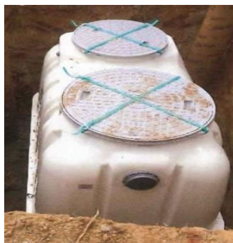
合併浄化槽の設置
