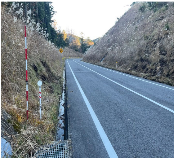
側溝蓋設置計画箇所 広域農道奥三河線（西納庫地内）
