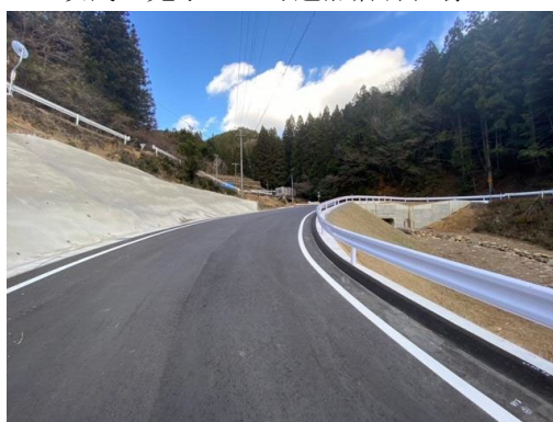
改良が完了した町道黒倉神田線
