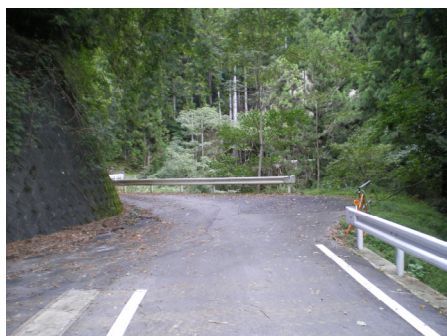
田峯東区田内線（状況）
