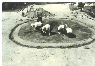
支柱を建てるための穴掘り作業
