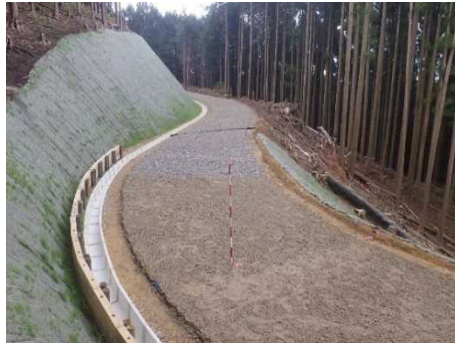
整備中の林道
