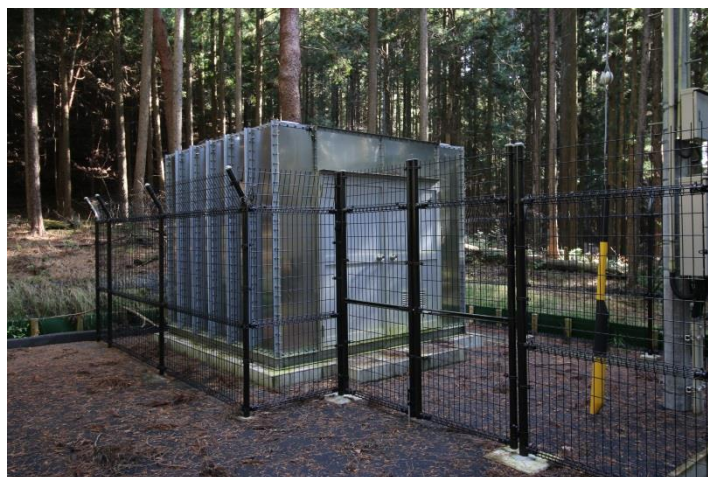
【西納庫増圧ポンプ場】
