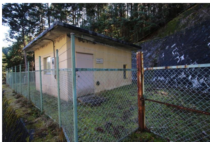
【森古屋配水池】
